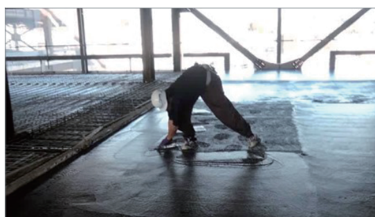
土間工による作業状況
